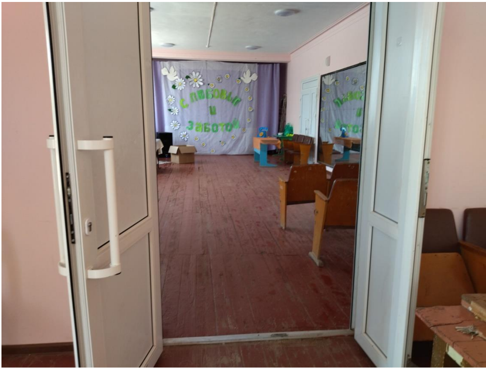
Фото № 7 Вход в танцевальный зал
