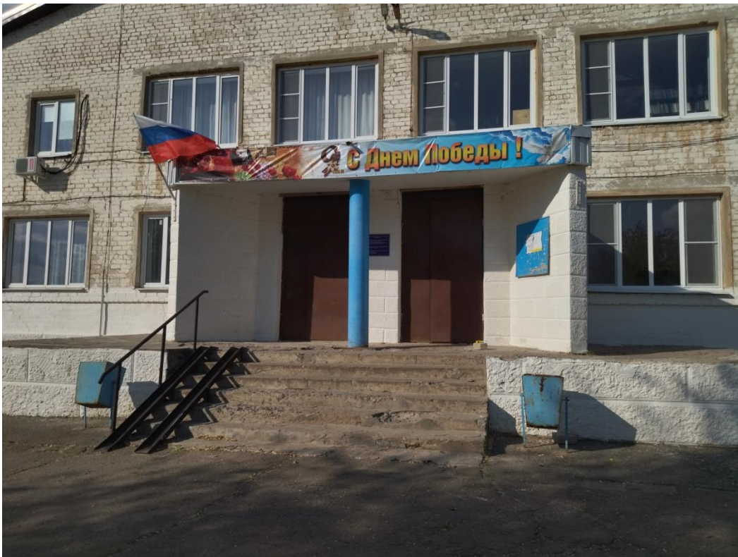
Фото № 2 входная площадка
